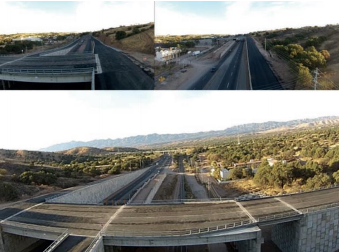
IMAGEN 1. VISTA SUR-NORTE (SUPERIOR) Y VISTA AÉREA NORTE-SUR DE RAMPA LATERAL IZQUIERDA EN EL PASO A DESNIVEL "PUENTE UNIVERSITARIO" EN NOGALES.
