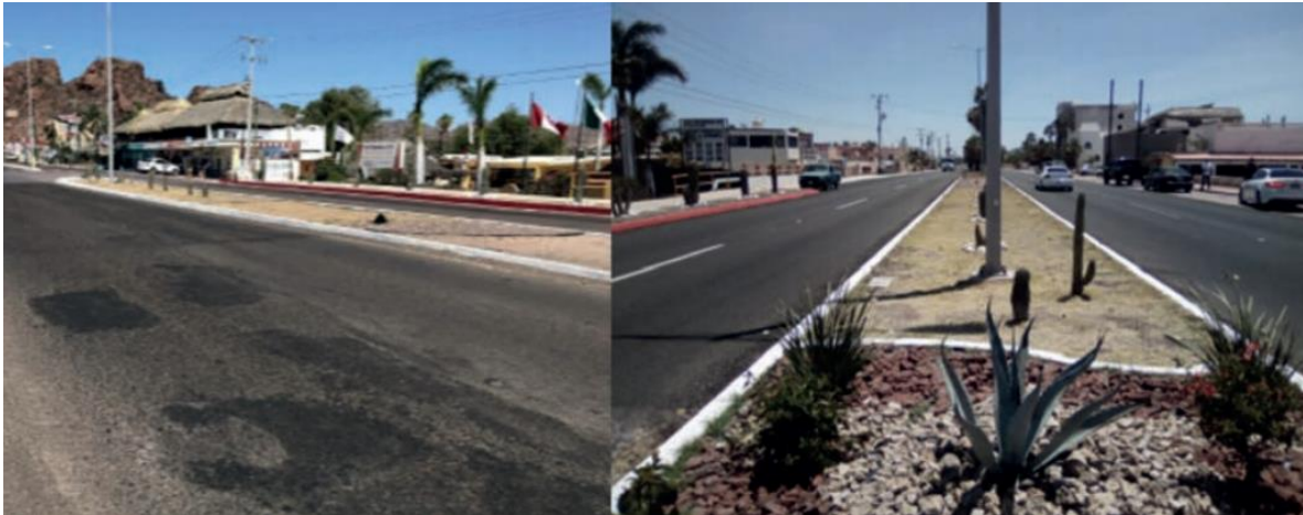
IMAGEN 2. REHABILITACIÓN DEL BULEVAR MANLIO FABIO BELTRONES RIVERA.
