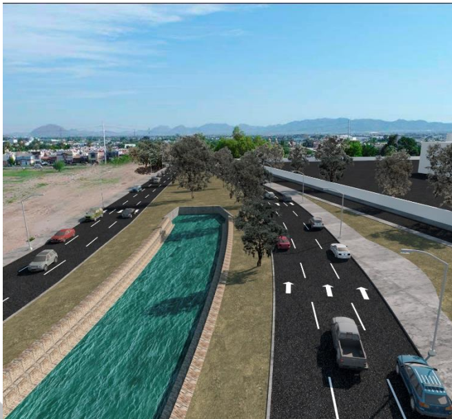
Construcción del Blvd. Quintero Arce
