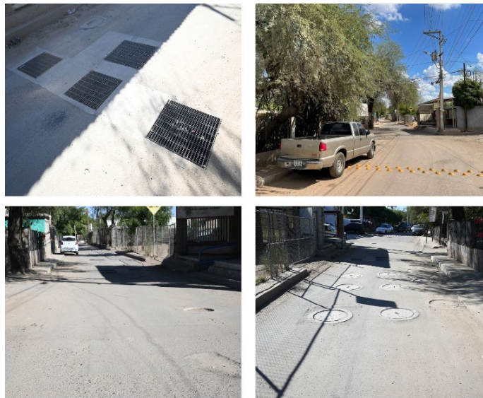
Imagen. Drenaje pluvial y pavimentación de la calle Juan Diego, en Hermosillo
