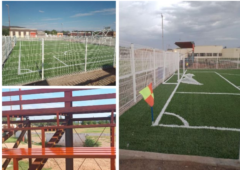
Imagen. Construcción de cancha infantil, en el municipio de Sahuaripa.
