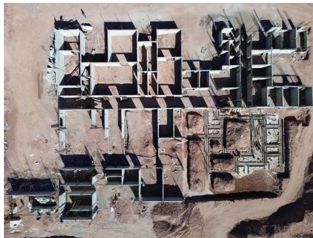
Imagen. Primera Etapa del edificio del Servicio Medido Forense, en el municipio de Guaymas.
